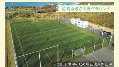
※復旧工事のため現在使用停止中
